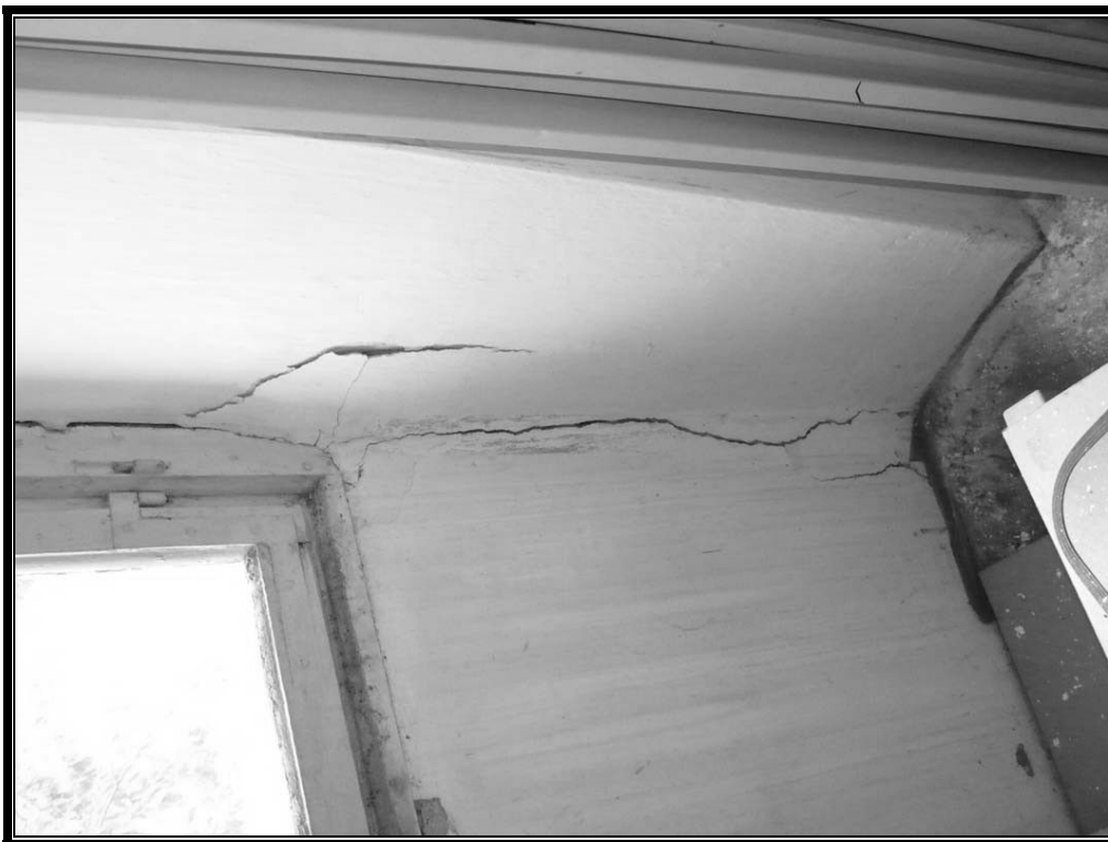
Fessurazioni muratura portante piano primo
