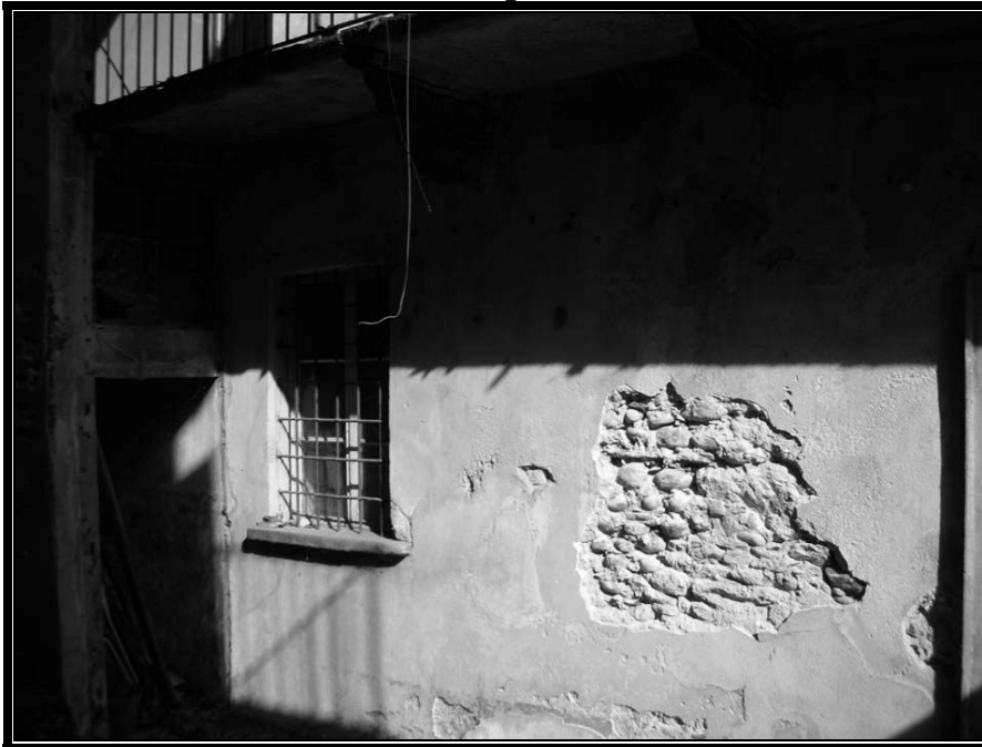
Muratura portante lato cortile piano terreno
